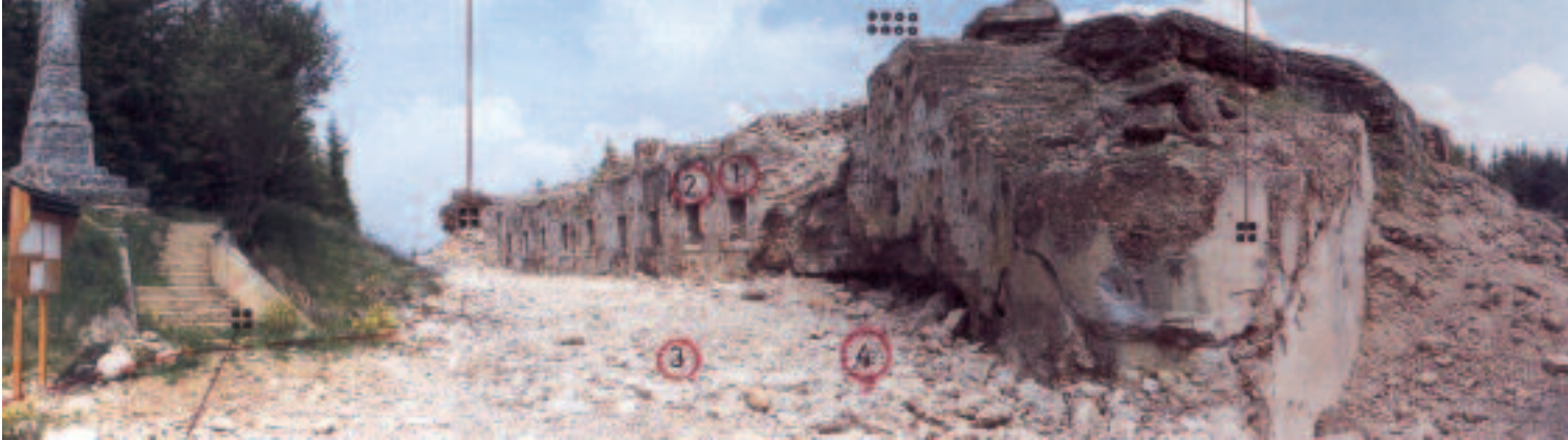
Il Forte Lusern nell’anno 1990 all’inizio dei lavori effettuati dalla Provincia autonoma di Trento - Servizio Ripristino e Valorizzazione Ambientale e dal Comune di Luserna (proprietà Servizio Valorizzazione e Ripristino Ambientale della Provincia autonoma di Trento)
