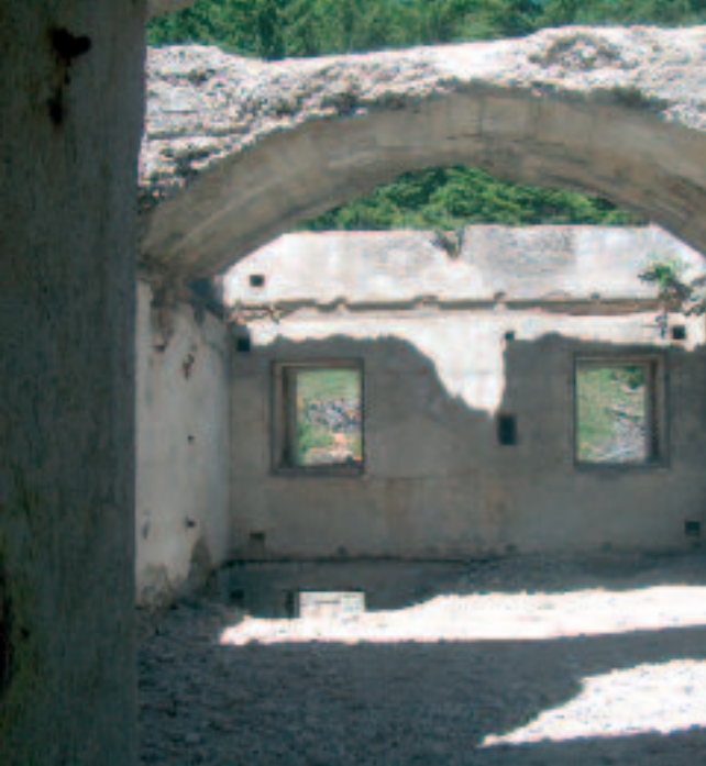
Forte Lusern 2006: locale sgomberato al primo piano
