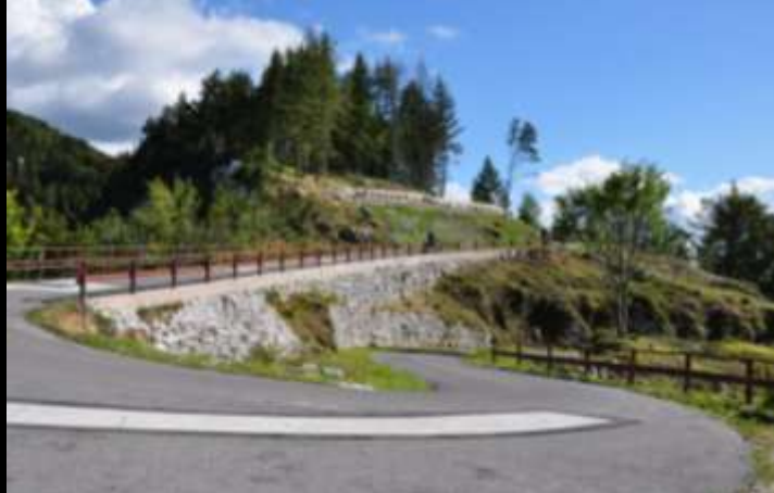
Veduta dall'avamposto italiano di destra verso la prima linea italiana. Prima e dopo l'intervento
